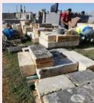
Une partie du mur de l'ancien cimetière a dû être modifié car il menaçait de s'effondrer. Il a été démonté, puis remonté sur un rang, une ouverture est prévue pour passer de la partie ancienne à la partie nouvelle.
